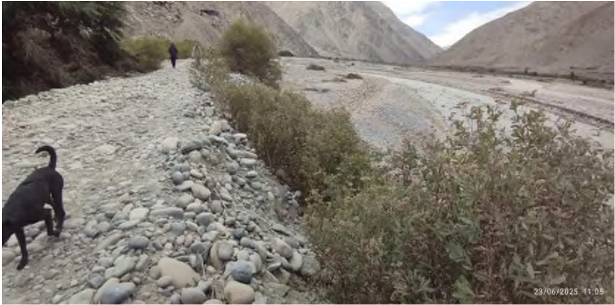
FIGURA N°02: TRAMO CRITICO 02, TALUD Y BASE DE TALUD SOCAVADOS, ENROCADO EN BASE DE TALUD INEXISTENTE
