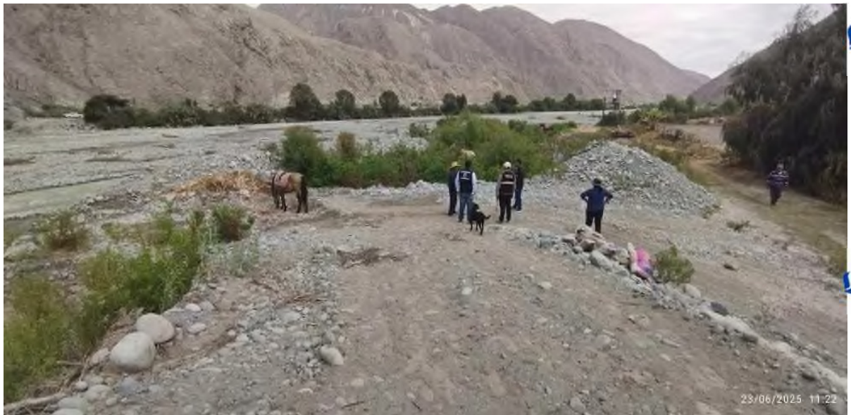
FIGURA N°03: TRAMO 03 FALTA DE DIQUE Y ENROCADO, AGUAS ABAJO ANDARIVEL EN PELIGRO.
